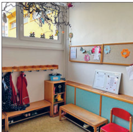
Renovierte Garderobe in der Kita Wirbelwind
