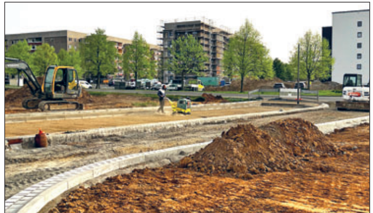
Wohngebiet Leipziger Straße während der Erschließung
